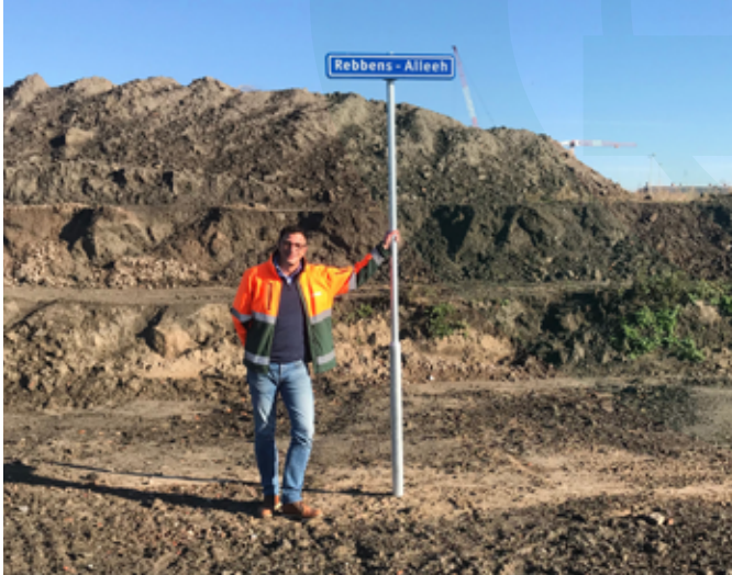
Aanleg bouwweg RMI terrein INFRA & MILIEU
