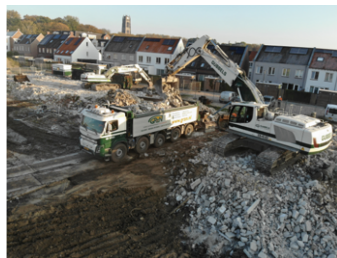
Zaltbommel SLOOP & ASBESTSANERING
