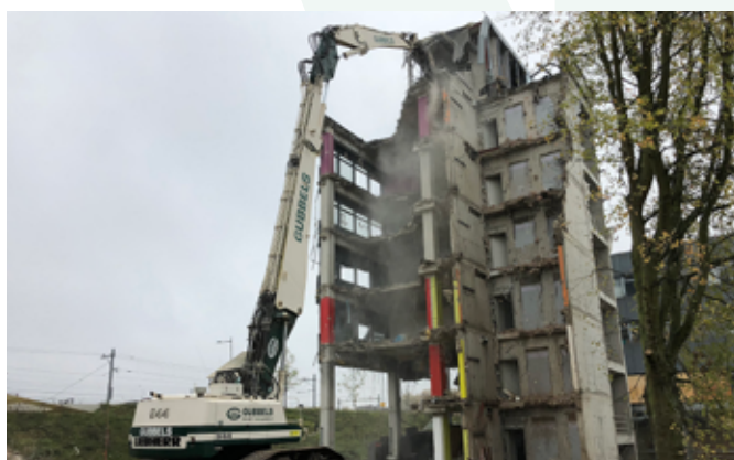
Den Bosch SLOOP & ASBESTSANERING
