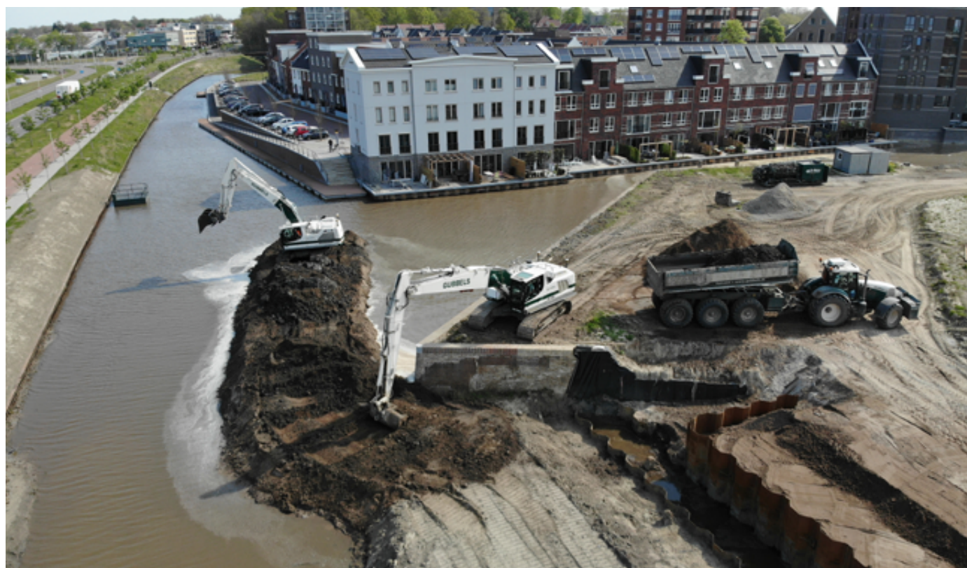
Nieuwe vesting perceel 4 & 7 INFRA & MILIEU
