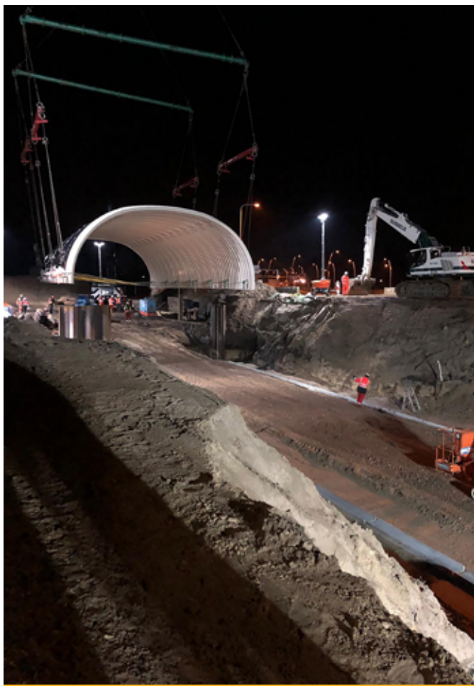
Fietstunnel Efteling Kaatsheuvel GRONDWERK & FUNDERINGSWERKZAAMHEDEN
