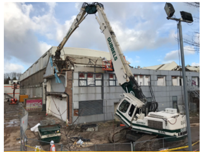
Sloop gebouw 68 SLOOP & ASBESTSANERING
