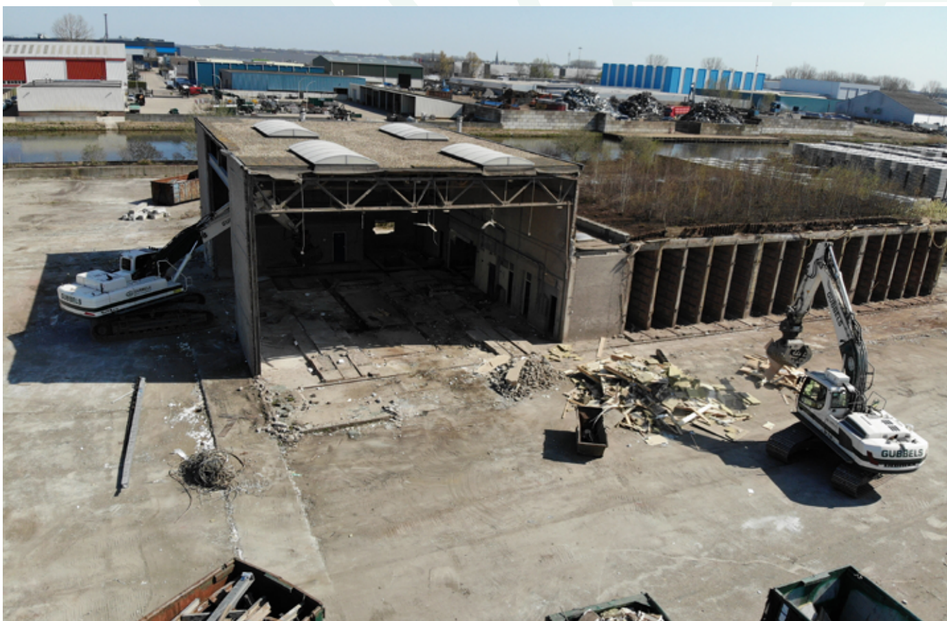
Waalwijk SLOOP & ASBESTSANERING
