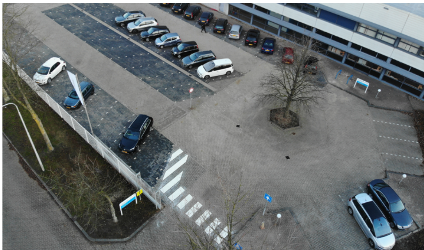
Parkeerterrein FABORY INFRA & MILIEU
