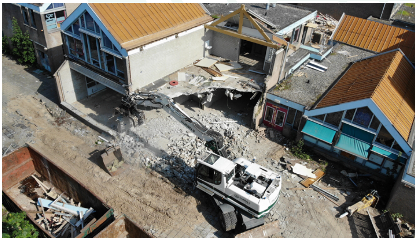
Sloop basisschool SLOOP & ASBESTSANERING
