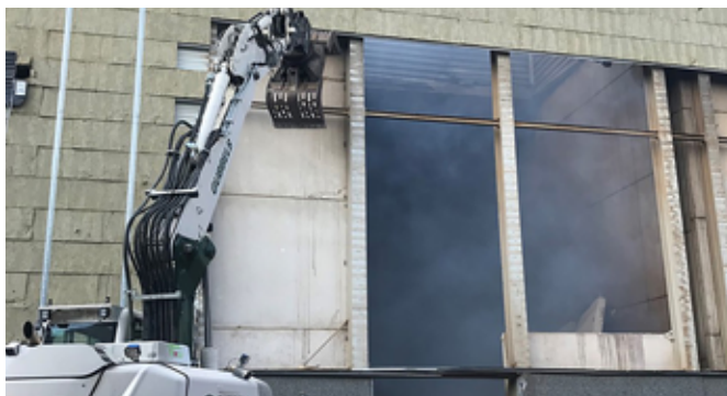
Brandschade Oss SLOOP & ASBESTSANERING
