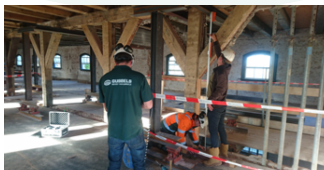
Stut- en vjzelwerken Seeligkazerne Breda SLOOP
