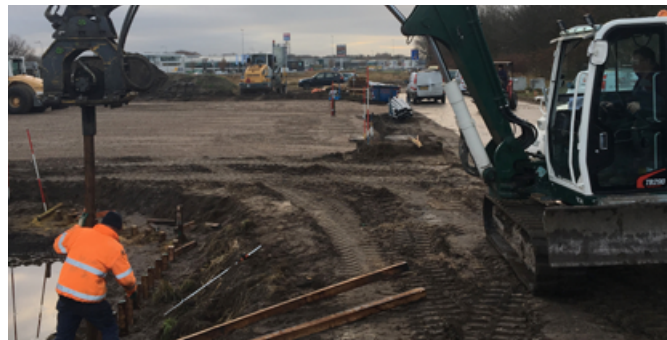
Gemeente Heusden, Nieuwkuijk INFRA
