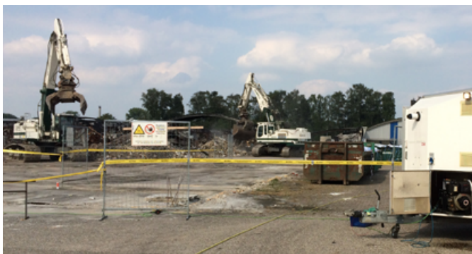
Katwijk, hallencomplex “zwarte markt” SLOOP
