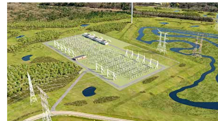
Het nieuwe hoogspanningsstation bestaat uit dertien velden en drie transformatoren die de stroom van 380 kV naar 150 kV omzetten.
