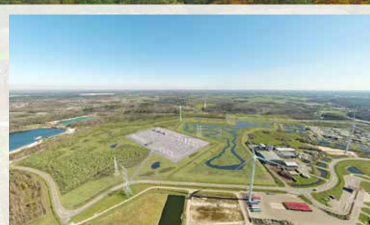
Het totale werkkerrein beslaat zo'n 35 hectare. Hiervan is ca. 6,5 hectare (13 voetbalvelden) bestemd voor het hoogspanningsstation zelf.
