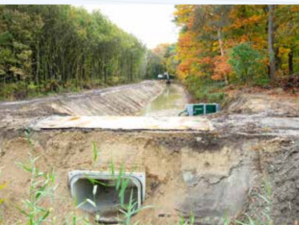
Het afgelopen jaar is hard gewerkt om de grond bouwrijp te maken en wordt er hard gewerkt om de waterberging te verplaatsen.
